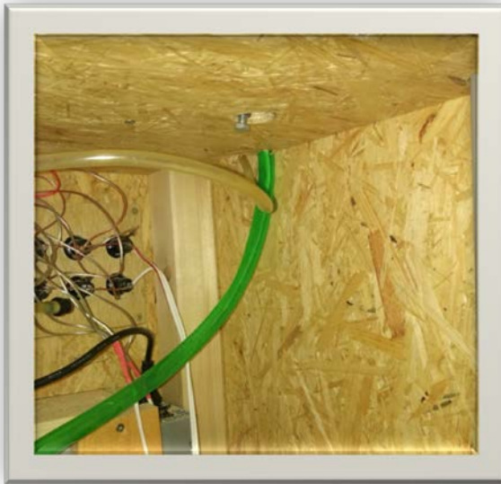
Bild 7): Isopropanolzulauf (gelber Schlauch)
